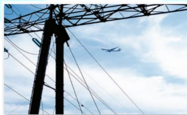
Filiformes : Lignes électriques, lignes de télécommunication, etc.
